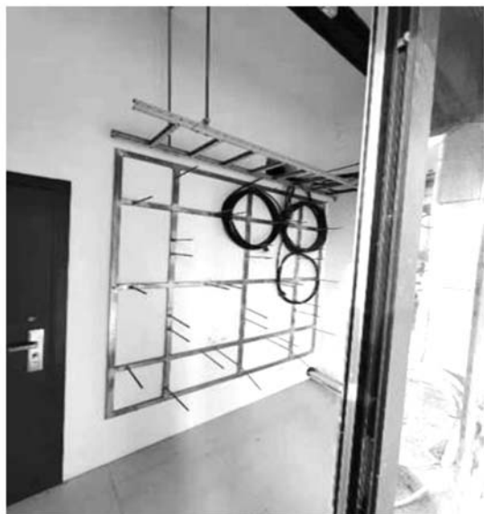
图6 某市东慧汇聚机房光缆进局盘留示意图 盘缆架工艺要求:
